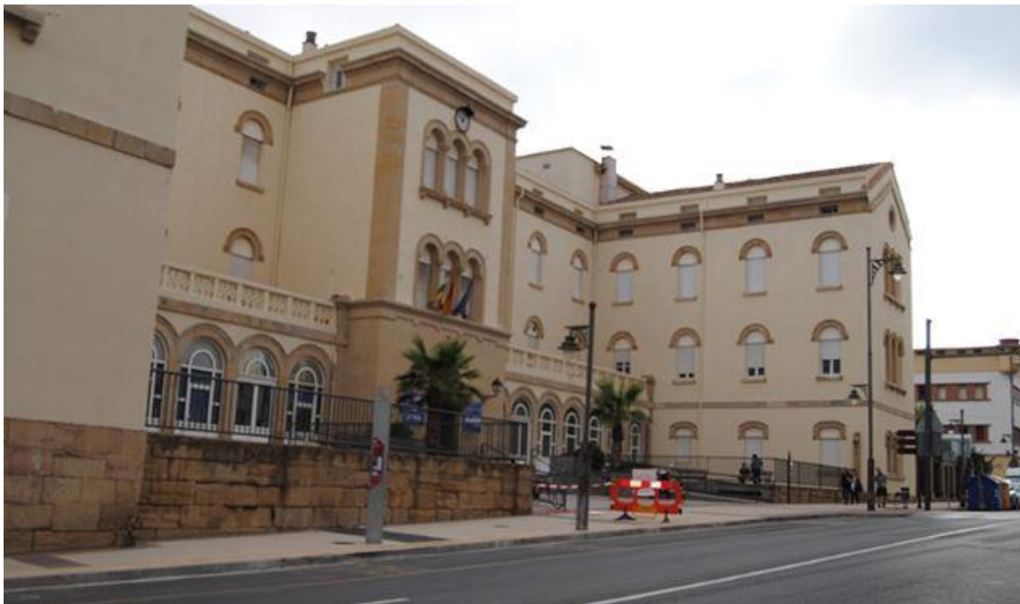
Fachada principal del Hospital General de La Rioja.
